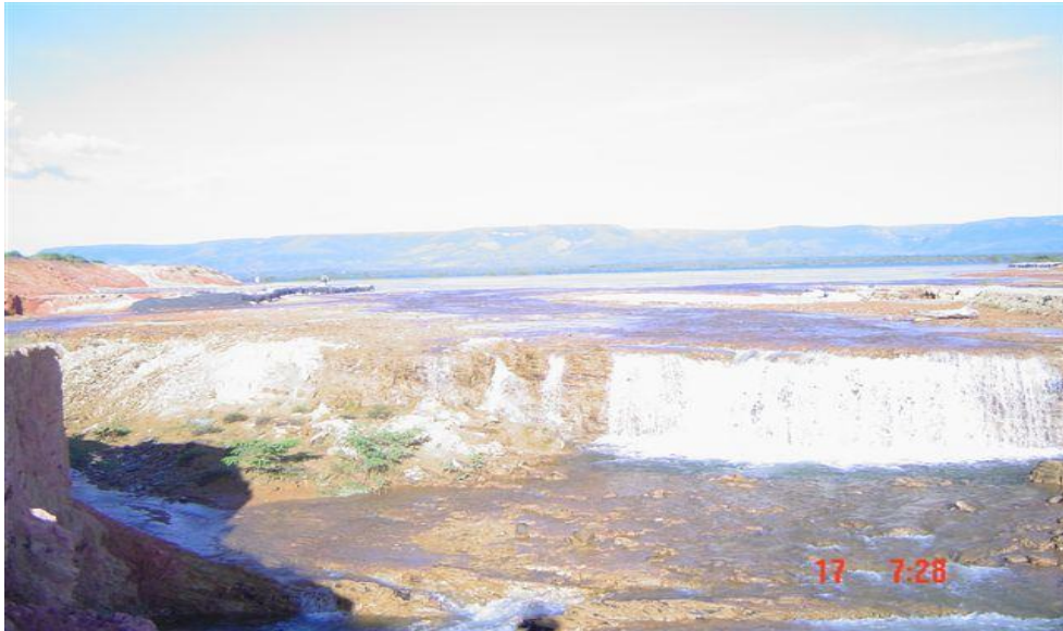
Figura 8.1 - Processo de erosão devido à liberação do vertedouro de emergência (DIDEC, 2004).
