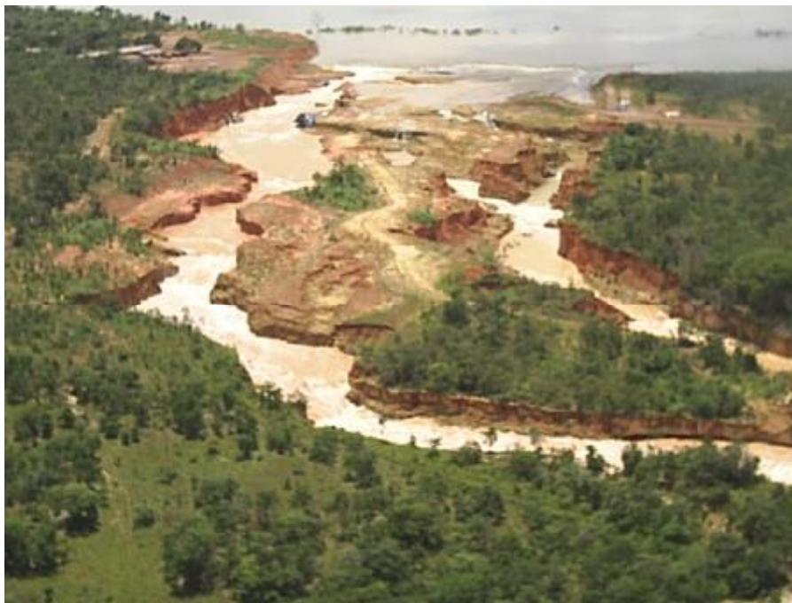
Figura 8.2 – Erosão a jusante da barragem de Flores de Goiás (DIDEC, 2004).
