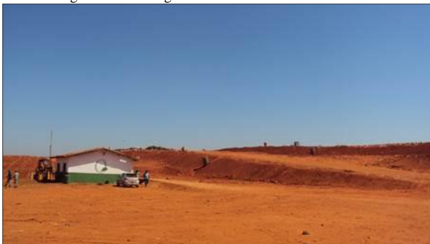
Figura 27 – Vista geral do aterro sanitário. Julho 2013.
