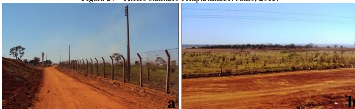
(a) vias de trânsito interna; (b) área cercada, mas sem cinturão verde.
