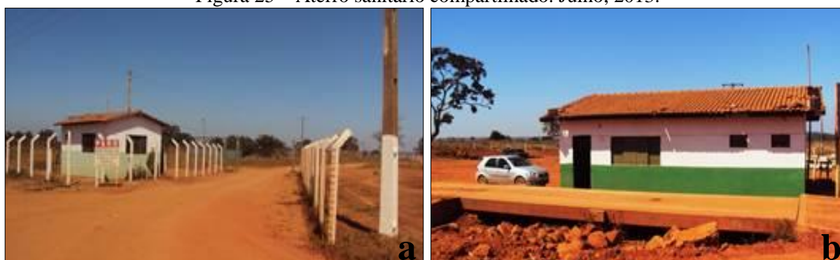
(a) guarita de entrada; (b) prédio administrativo da balança.
