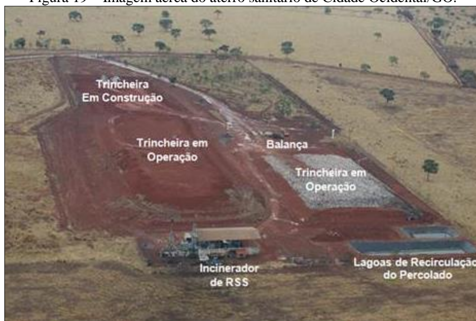
Figura 19 – Imagem aérea do aterro sanitário de Cidade Ocidental/GO.
