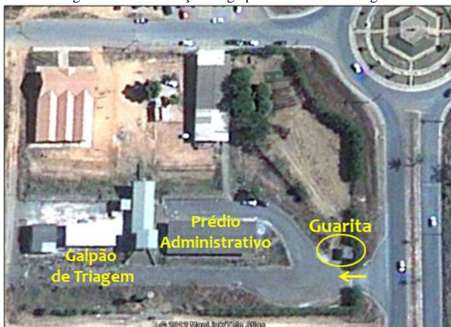
Figura 14 – Localização do galpão da central de triagem.
