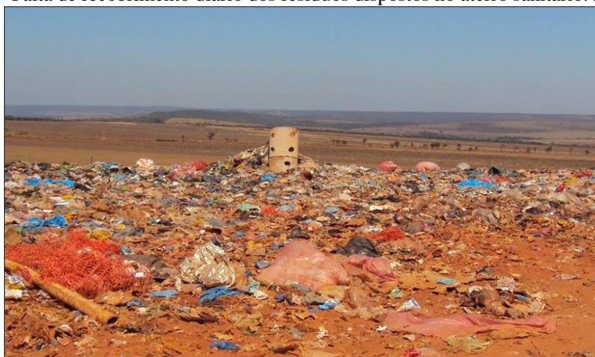
Figura 28 – Falta de recobrimento diário dos resíduos dispostos no aterro sanitário. Julho, 2013.
