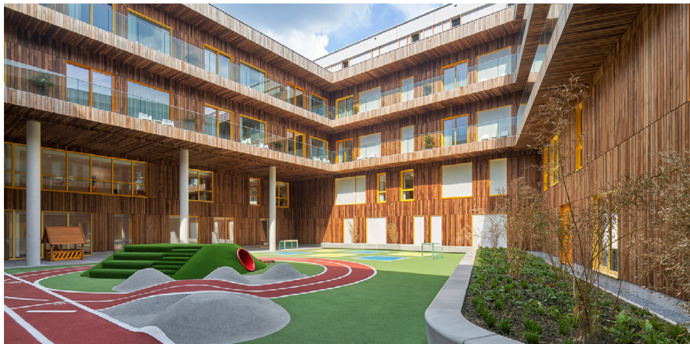
Figura 28: Pátio interno do Centro de Oncologia Infantil Princess Máxima . Foto: Ronald Tilleman, s.d. Fonte: Archdaily, 2019. Disponível em: < https://www.archdaily.com.br/br/912899/centro-de-oncologia-infantil-princess-maxima-liag-architects >. Acesso em 17 out. 2025.
