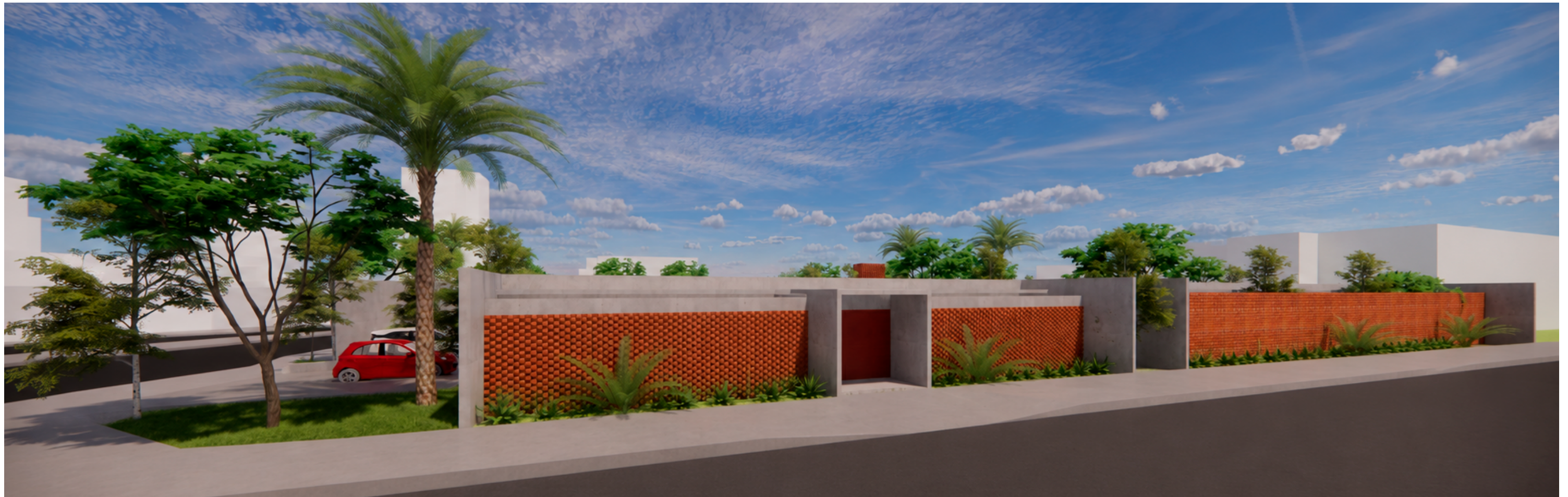
Figura 51: Fachada frontal. Fonte: da autora (2026), com auxílio de Inteligência Artificial.
